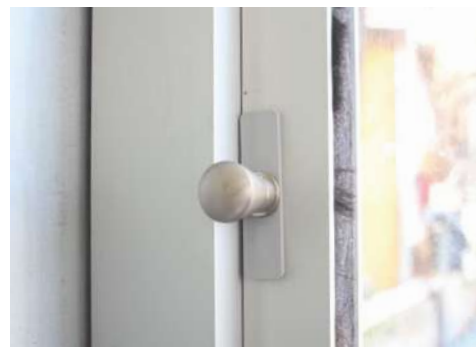
Compensatore con paletto per bloccaggio ante
